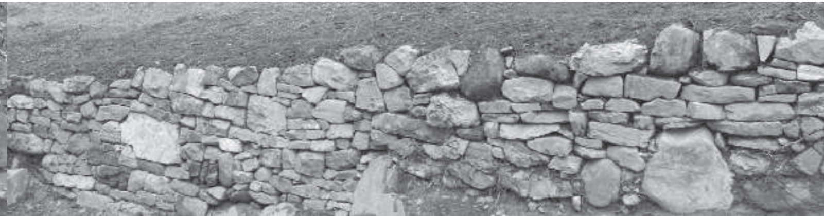
bauen nach den Regeln des Trockenmauer-Handwerks
