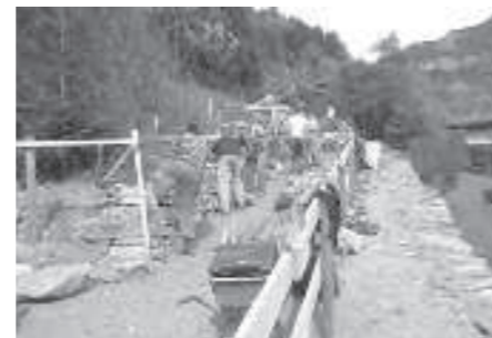
Sanierungsprojekt und Mauerbaukurs Alte Raggaler Straße, 2014, Ludesch
