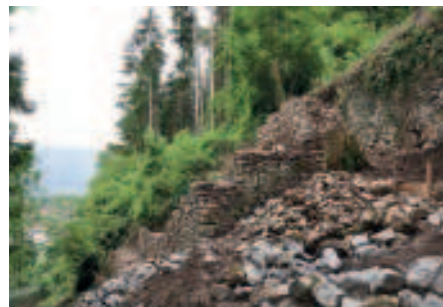
Sanierte Stützmauern und Steintreppe, Vanovagasse, Bludesch und Thüringen
