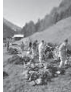
Sanierung und Mauerbaukurs Alte Straße Großes Walsertal, 2014, Sonntag, Abteilung Straßenbau (VIIb)
