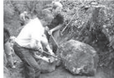
Sanierungsarbeiten im Zuge eines Trockenmauerbaukurses, 2015, Alter Schafweg, Bürs
