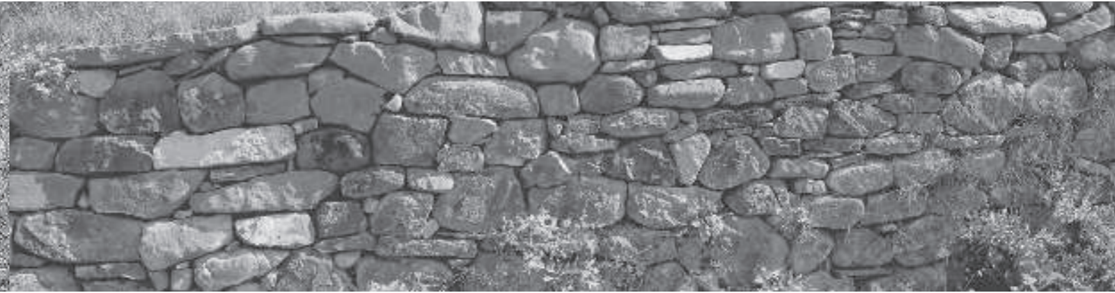
harmonisches Einfügen mit ähnlichem Material und ähnlicher Steinform
