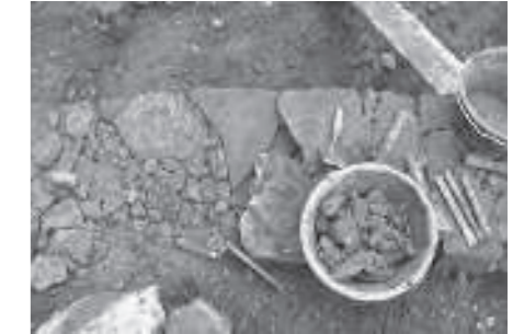
Eingesetzte Werkzeuge bei der Mauersanierung, Vanovagasse, Bludesch und Thüringen
