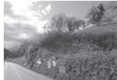
Stützmauer für ehemaligen Weingarten, Röns
