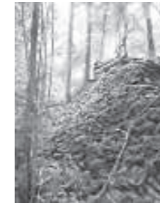
Mächtige Stütz- und Fundamentmauer für Heubarge, Nüziders
