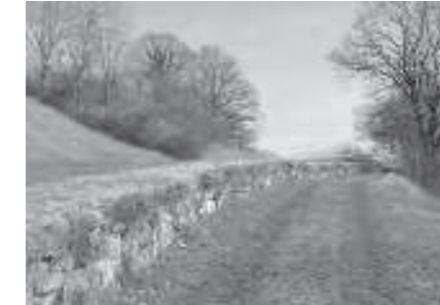
Stützmauer Alte Landstraße, Röns
