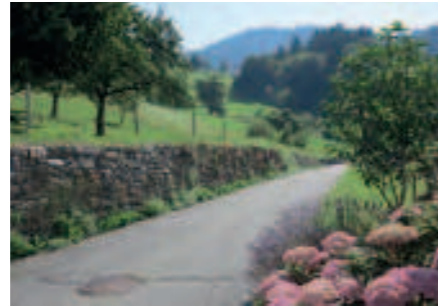
Straßenbegleitende Stützmauer, Batschuns-Grätscha, Zwischenwasser
