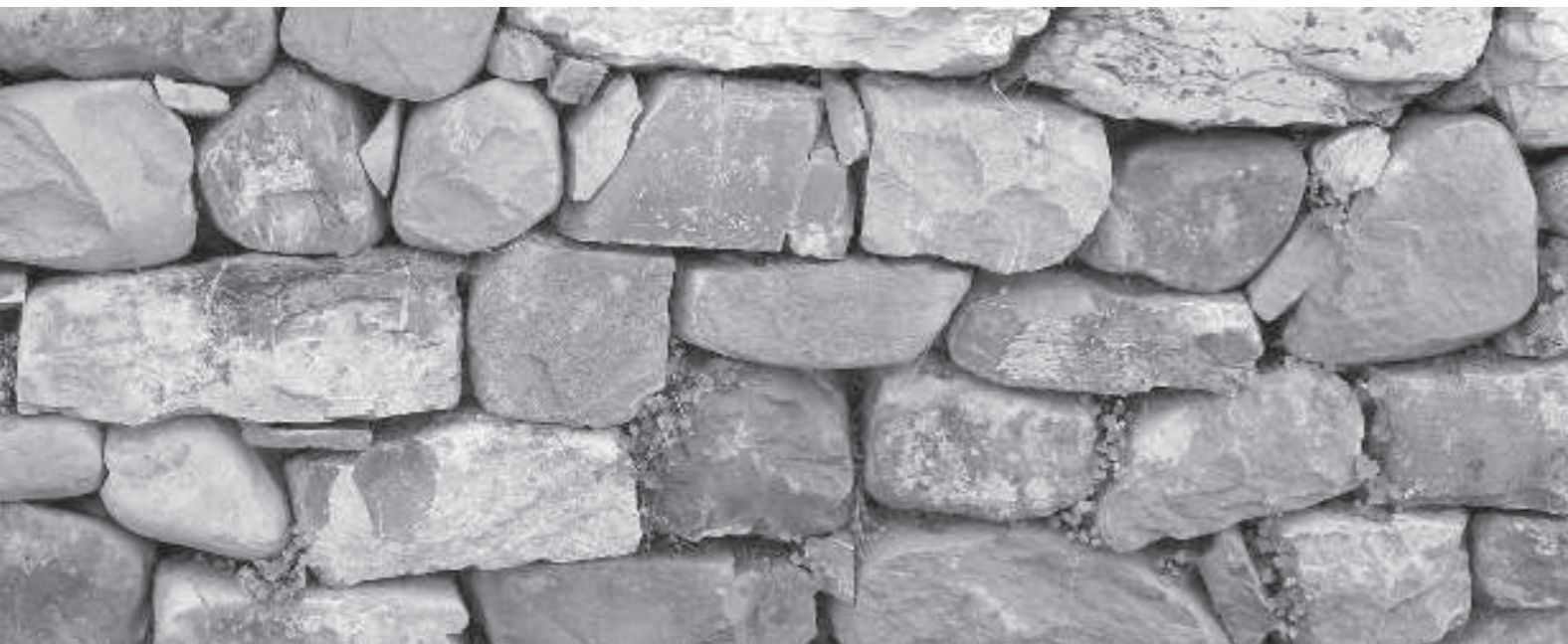
regelhafter Verband mit Lagerfugen
