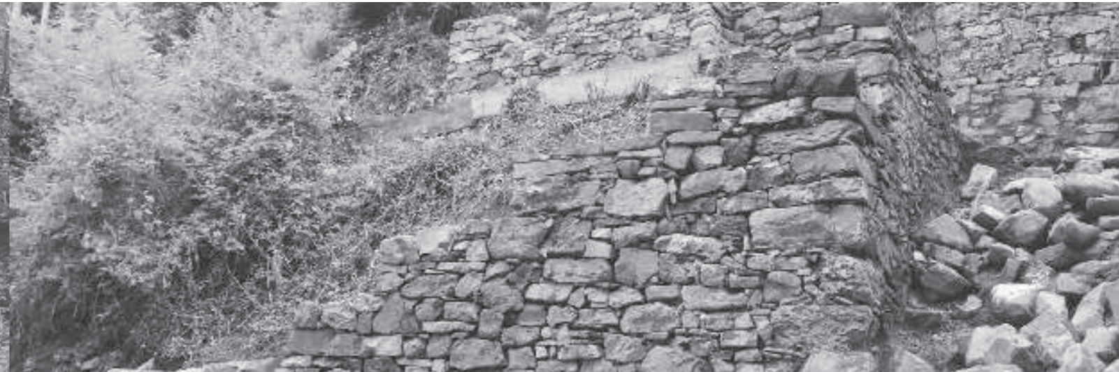
Wiederaufbau fehlender Mauerbereiche mit Orientierung am Bestand
