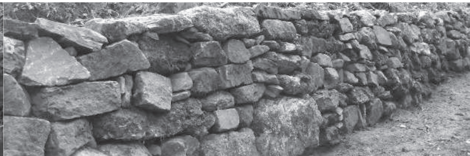
Sanierung mittels Neuerrichtung der Mauer
