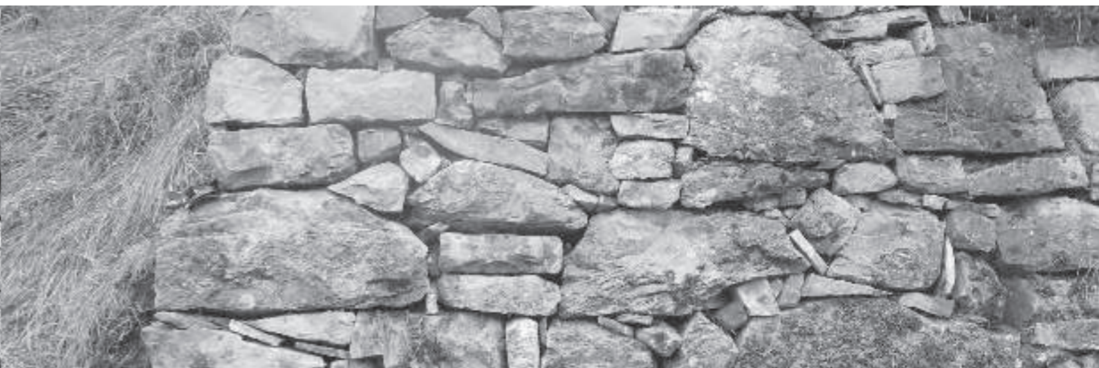
fehlende Steine nachgesetzt, Verbandswirkung wieder hergestellt
