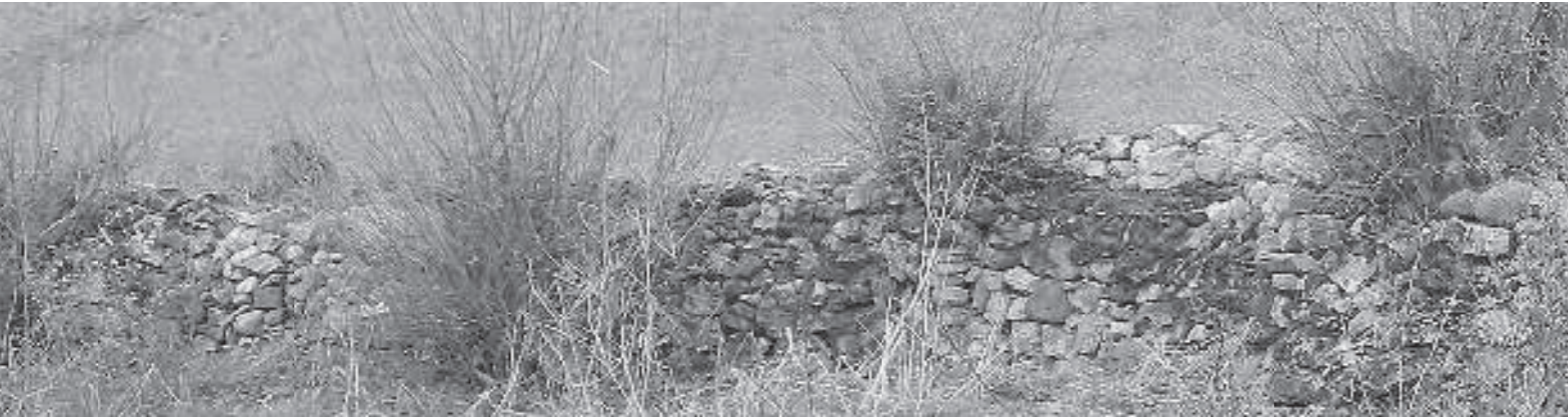
Verwendung von anderem Material und anderen Steinformen
