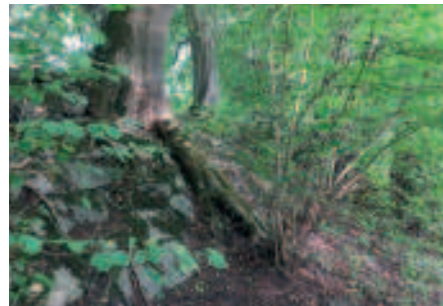
Hochwasserschutzmauer Alter Rhein, Lustenau
