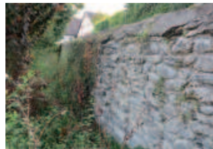
Wegbegleitende Stützmauer Basilika, Liebfrauenberg, Rankweil
