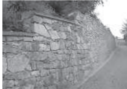
Wegbegleitende Stützmauer, in mehreren Etappen saniert, Liebfrauenberg Rankweil
