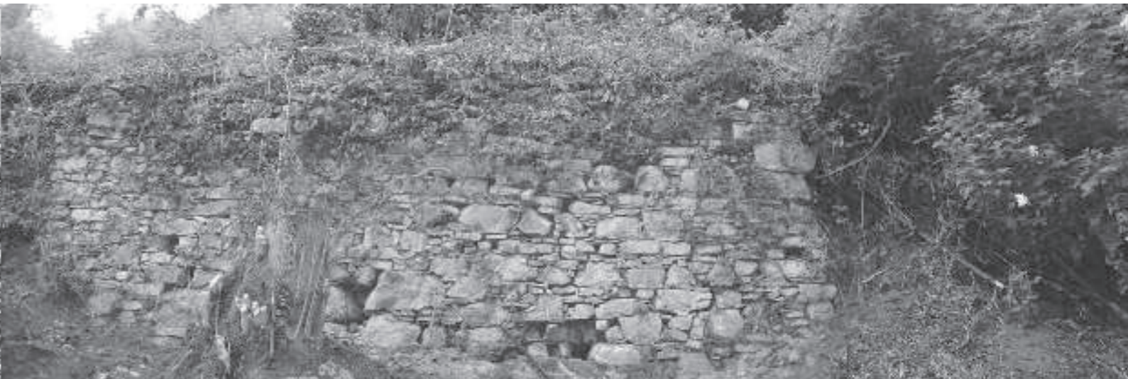
Gehölzaufwuchs mauerschonend entfernt
