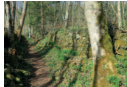
Beidseitig wegbegleitende Stützmauern, Alter Schaßweg, Bürs
