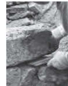
Sanierungsarbeiten an einer Trockensteinmauer, Vanovagasse 2015, Bludesch und Thüringen
