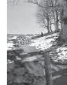
Sanierte Einfriedungsmauer und wegbegleitende Mauer, Nenzinger Berg, 2015
