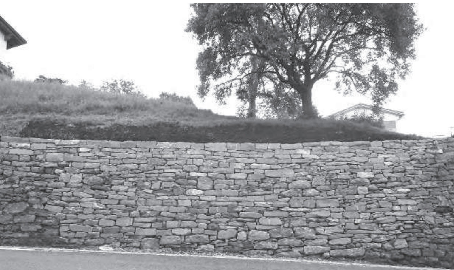
Best-Practice-Beispiel fachgerechten Trockenmauerbaus: Sanierung straßenbegleitender Stützmauer Achrain Dornbirn, 2016, durch die Abteilung Straßenbau (VIIb)
