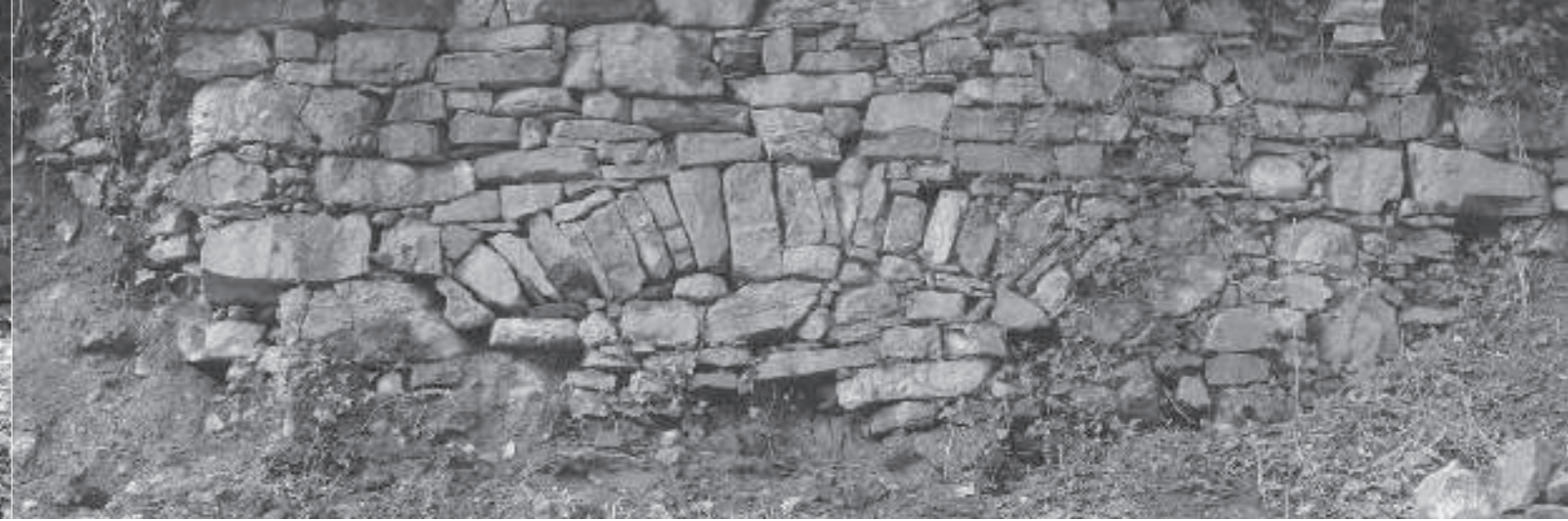
Schadstelle fachgerecht saniert
