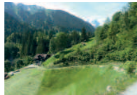
Wegbegleitende Stützmauer, Tschagguns
