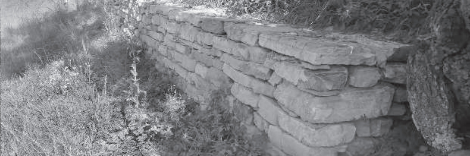
Mauer freigeschnitten und teils saniert
