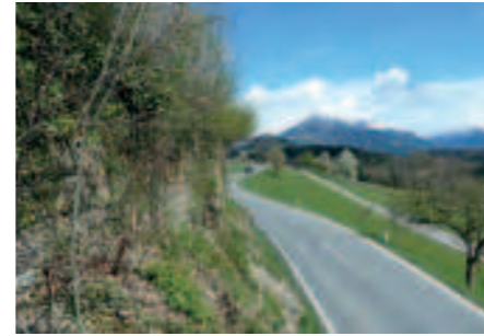
Stützmauer auf anstehendem Fels über Landesstraße, Röns
