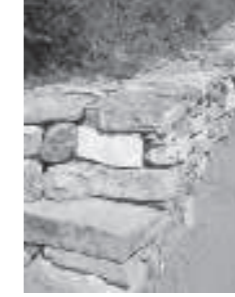
Trockensteinmauer mit Sitzbank, Sanierung 2014, Ludesch
