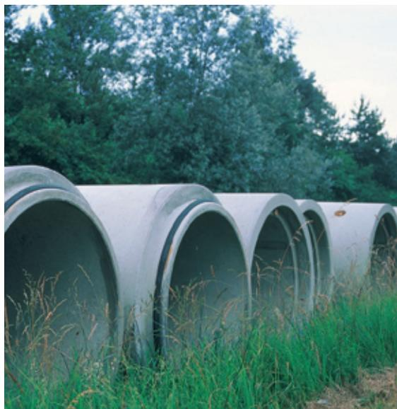
Abb 35: Betonrohre für Stauraumkanal
