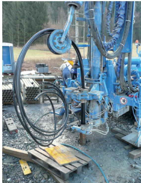
Abb 44: Bohrgerät für Erdsonde
