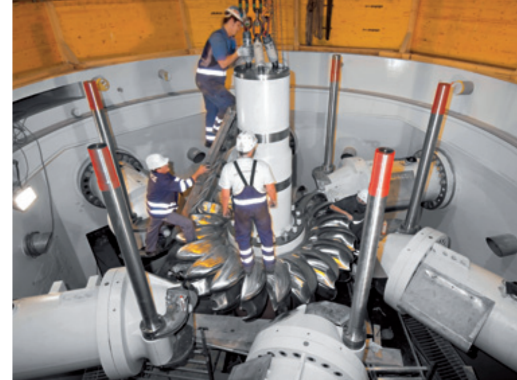
Montagearbeiten an der Pelton turbine im Kopswerk II.
