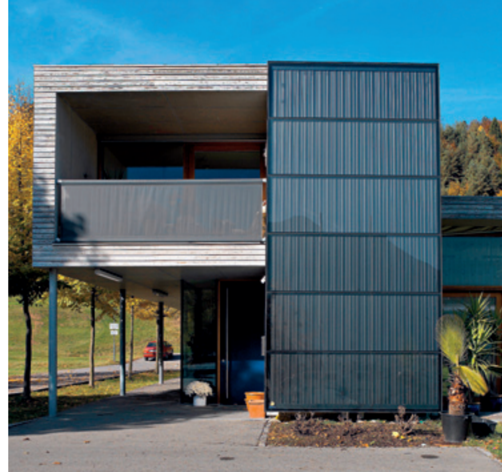
Solare Warmwasseraufbereitung auch für die Kleinsten im Kindergarten in Gais.
