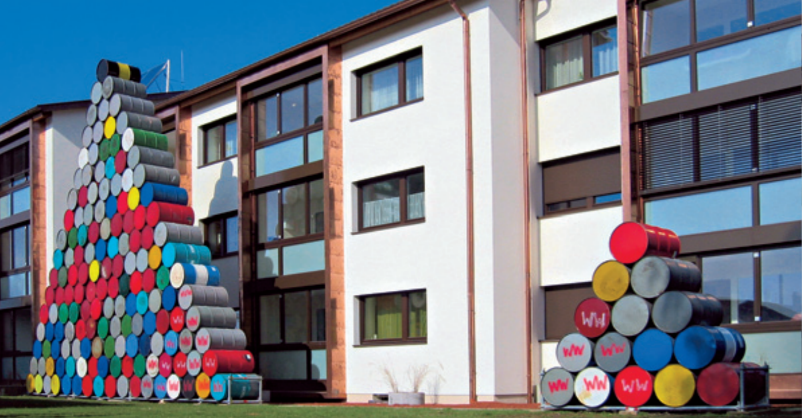
Faktor 10 Sanierung: VOGEWOSI Mehrfamilienhaus in Rankweil; Darstellung des Energieverbrauchs mittels Ölfässern vor und nach der Sanierung.
