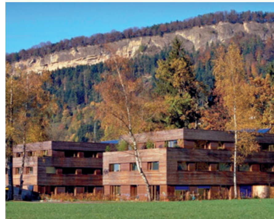
Zwei gleichartige Wohnhäuser in Passivhausbauweise mit je vier Wohneinheiten in Wolfurt.
