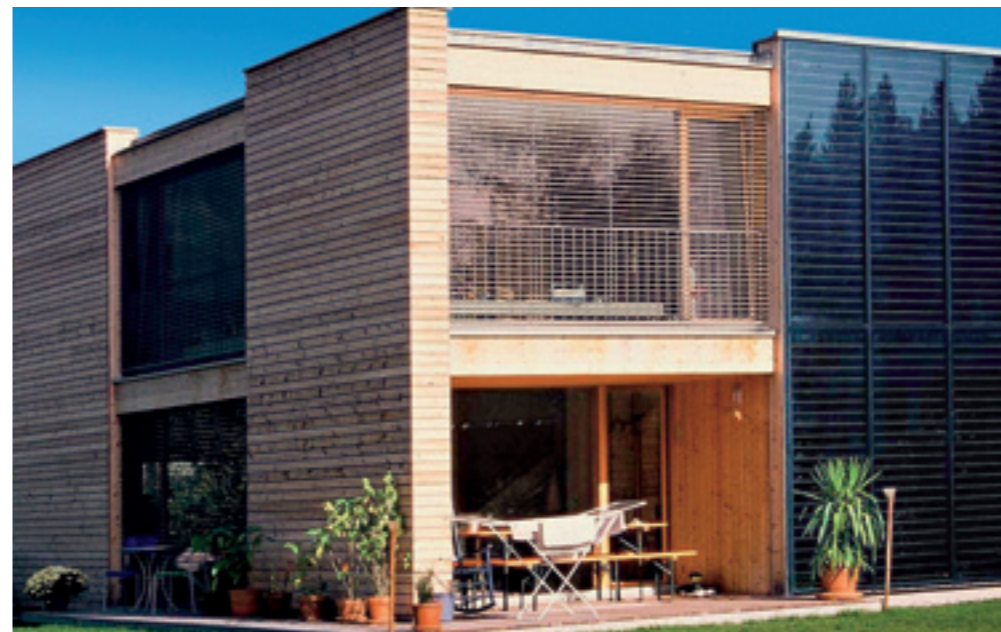
Fassadenintegrierte Solaranlage im Einfamilienhaus in Wolfurt.
