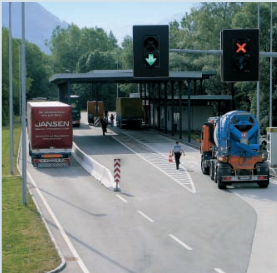
A 14 Kontrollstelle in Nüziders.
