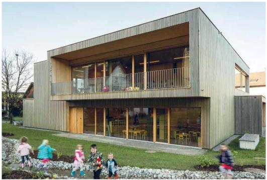
Der Kindergarten Muntlix ist durch gute Wärmedämmung, Verschattung und die hohe Speichermaße der Böden aus Stampflehm optimal vor sommerlicher Überwärmung und der Temperaturzunahme durch den Klimawandel geschützt. (Foto: Kurt Hoerbst, Rainbach. Architektur: HEIN architekten, Bregenz)
