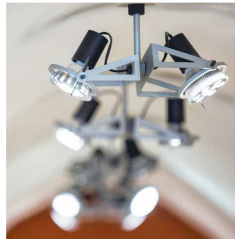
Der bestehende Sockel ermöglicht einen einfachen Austausch der Leuchtmittel.
