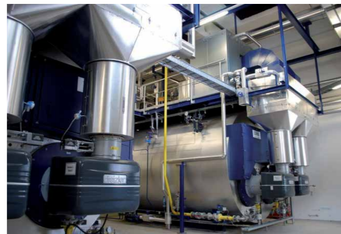
Bis zu 25 Tonnen Dampf werden in jedem Kessel pro Stunde erzeugt.
