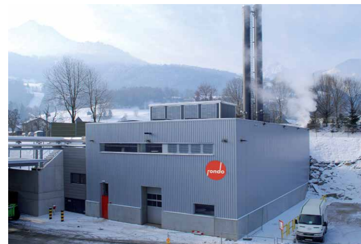
Seit Oktober 2011 sind die beiden Kessel im neuen Kesselhaus bei Rondo in Frastanz in Betrieb.
