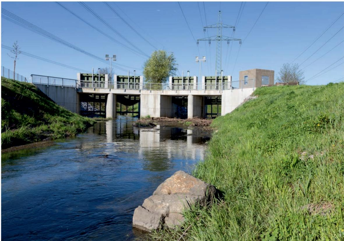
Oben li: Dachwasserretention. Oben re: Blauzone Rheintal. Unten: Ausleitungsbauwerk Rheintal-Binnenkanal mit Retention
